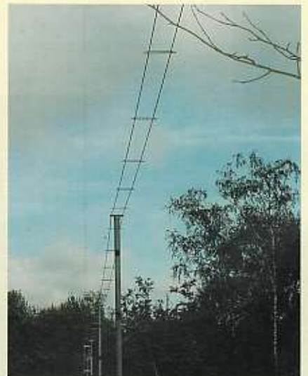
De kippenladder voedingslijn voor de dipoolantenne van 2 x 24 meter.
